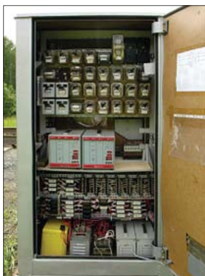
Рис. 4. Релейный шкаф системы АПС-МП
